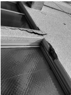
母島し尿処理場管理棟：外壁劣化部
