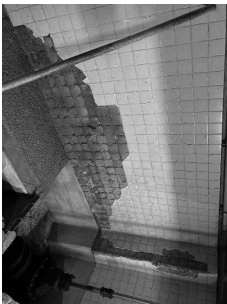
母島中継ポンプ場：ポンプ所劣化状況
